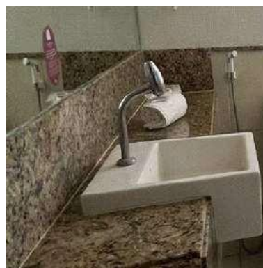
b. Válvula reguladora de água
