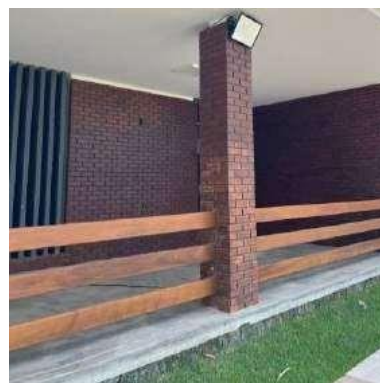
Área sem parede
