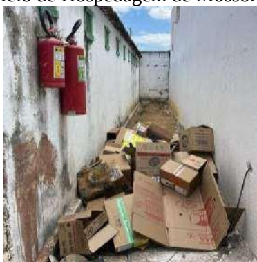
b. Controle de Desperdício
