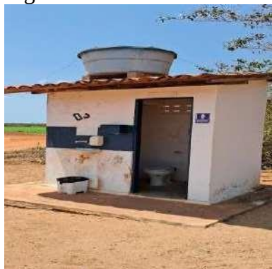
a. Instalações sanitárias
