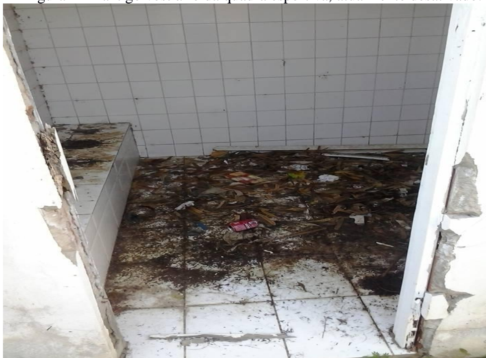
Figura 24 – antigo vestiário da quadra esportiva, atualmente desativado.
